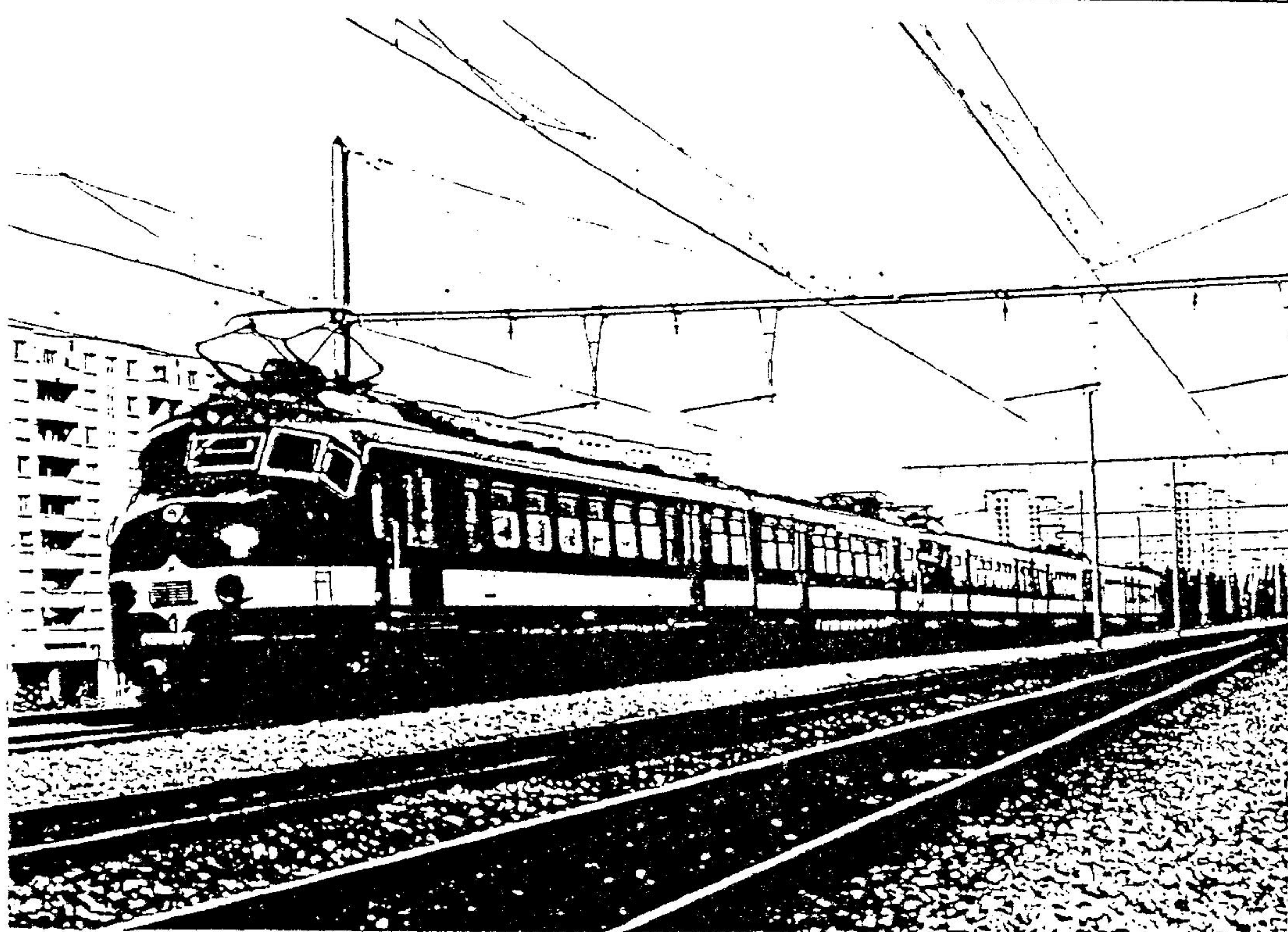
Foto : Beneluxstellen op de verbinding Brussel-Amsterdam Antwerpen-luchtbal Augustus 65
